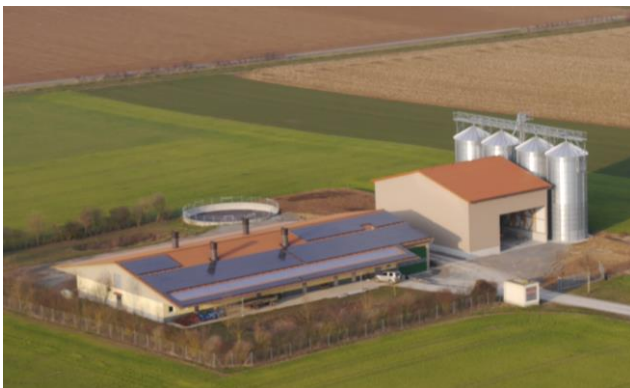
Aufzuchtstall mit Getreideanlage
